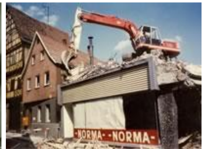
Das ehemalige Kaufhaus Orion in der Schieringerstraße wird abgerissen. Fotograf: Stefan Benning, Stadtarchiv Bietigheim-Bissingen.
