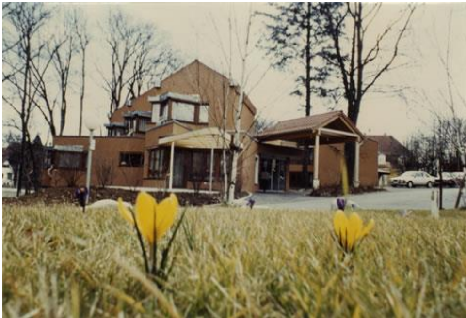
Eingangsbereich des "Wohn- und Pflegeheims für Multiple-Sklerose-Erkrankte am Lindenhain" (Pforzheimerstraße). Fotograf: unbekannt.
