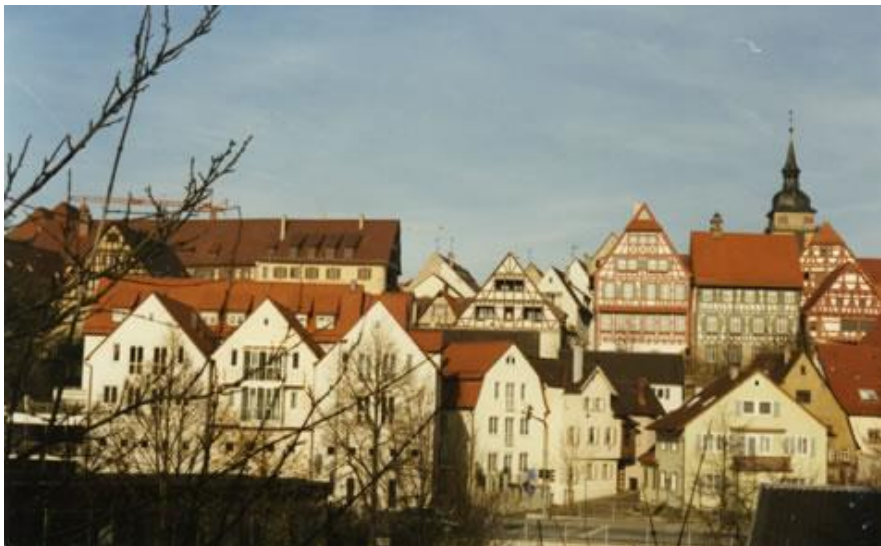
Das fertiggestellte Parkhaus mit den Wohnungen in den Obergeschossen. Aufnahme ca. 1988, Fotograf: unbekannt.
