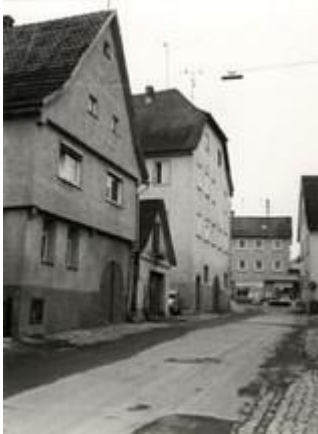
Haus Brückenstr.4 vor der Sanierung. Aufnahme 1976, Fotograf: Othmar Birkner.
