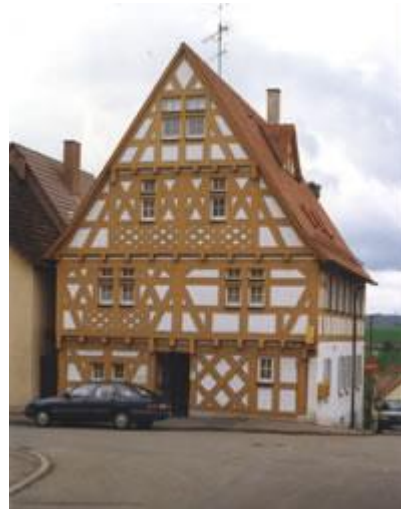
Das sanierte Fachwerkhaus in der Rathausstraße in Metterzimmern. Fotograf: Hans Huber.
