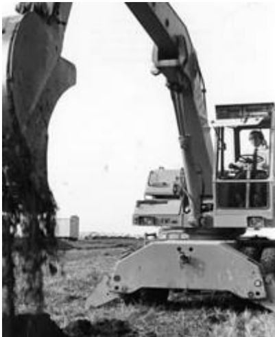
Erster Baggerbiss zum Freibad Ellental: am Steuer Oberbürgermeister Manfred List. Fotograf: Michael Nether.
