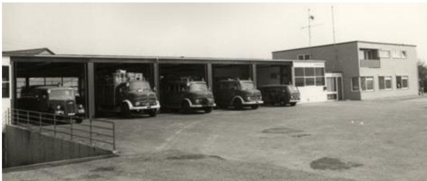
Das neue Feuerwehrgerätehaus der Bissinger Feuerwehr im Forchenweg, eingeweiht am 21.4.1978. Aufnahme: Alfred Drossel.
